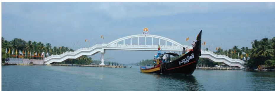
Amrita Setu, le pont construit par le MAM sur les « backwaters »
