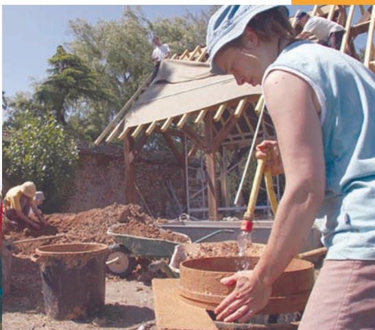
Construction de murs en terre et paille à l'ashram français
