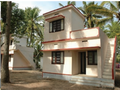
Tyypillinen tsunamikatastrofin jälkeen avustuksena rakennettu talo Keralassa
