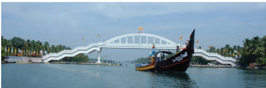
MAM:n rakentama, Keralan takavesien yli vievä Amrita Setu –evakuointisilta
