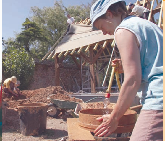
Muren bouwen met klei en stro in de Franse ashram
