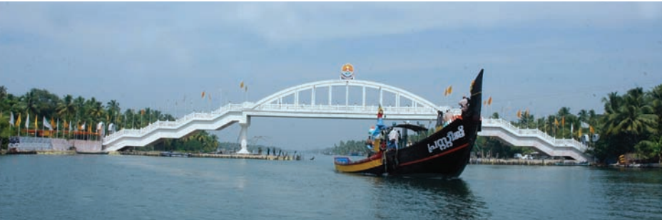
Amrita Setu, de evacuatiebrug gebouwd over de backwaters in Kerala door de M.A.Math
